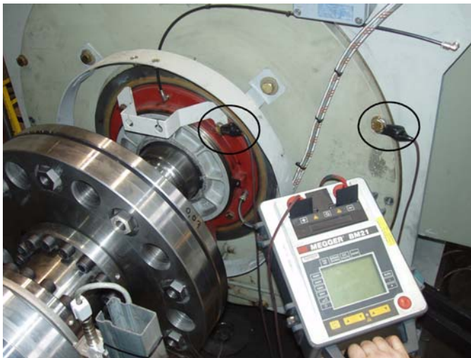
Рисунок 7-4 Измерение сопротивления изоляции роликового подшипника
